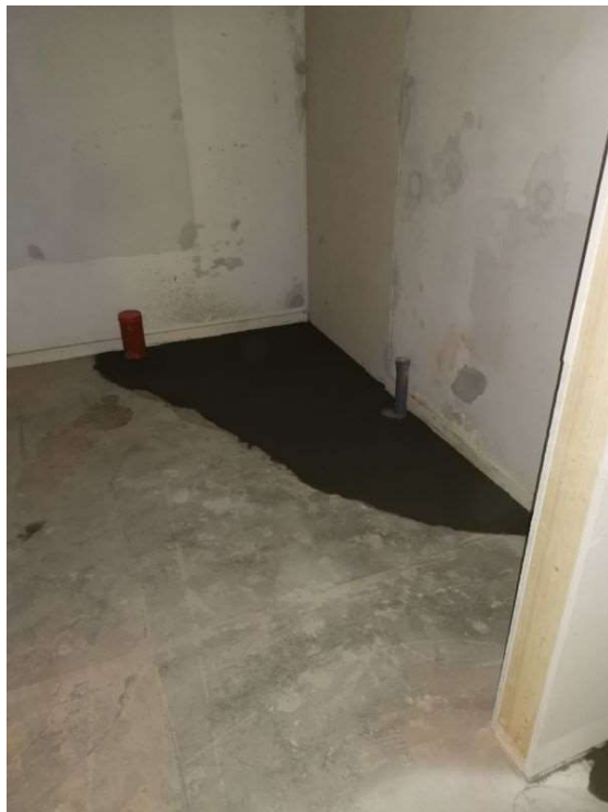
Det nye toilet.
