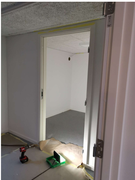
Det nye toilet.
